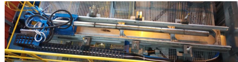
Lanca wtryskowa gotowa do pracy na kotle WR25
