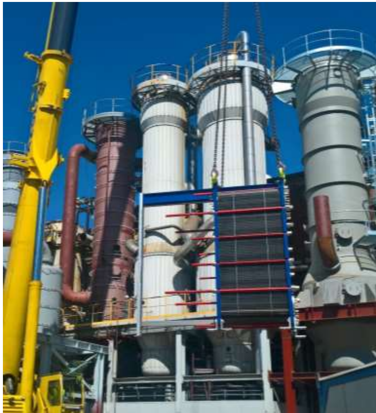
Nowy ogrzewacz soku do defekacji głównej
