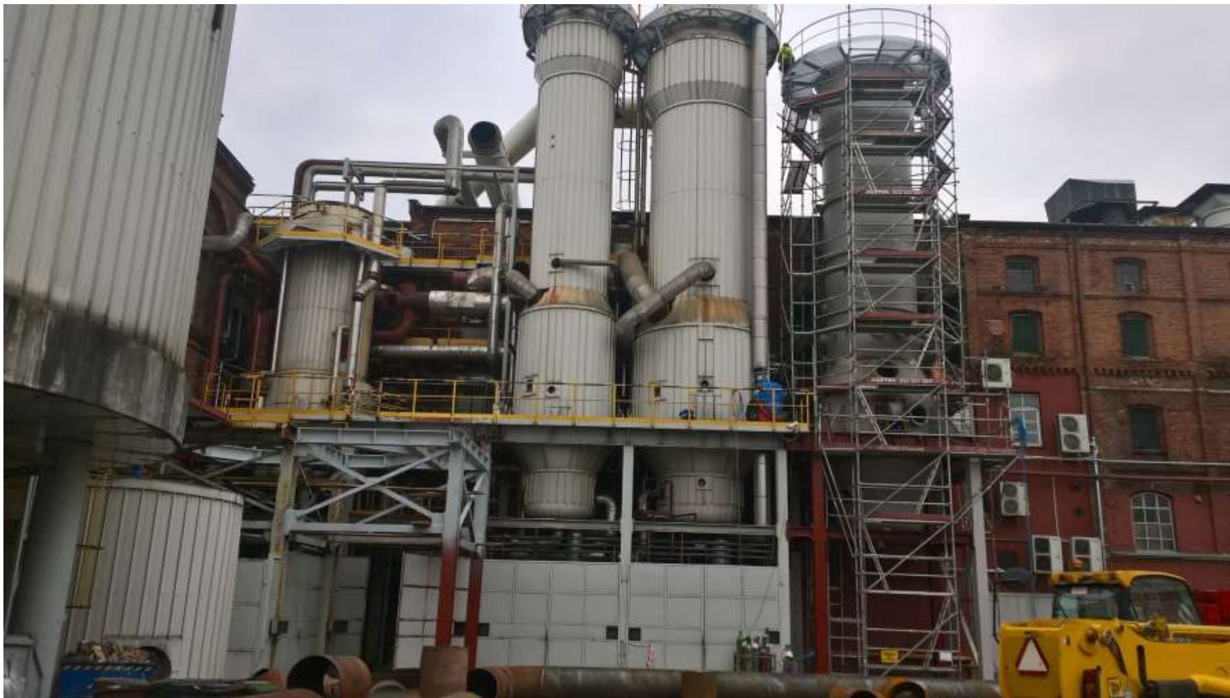
Prace na rurociągach i opadowych aparatach wyparnych
