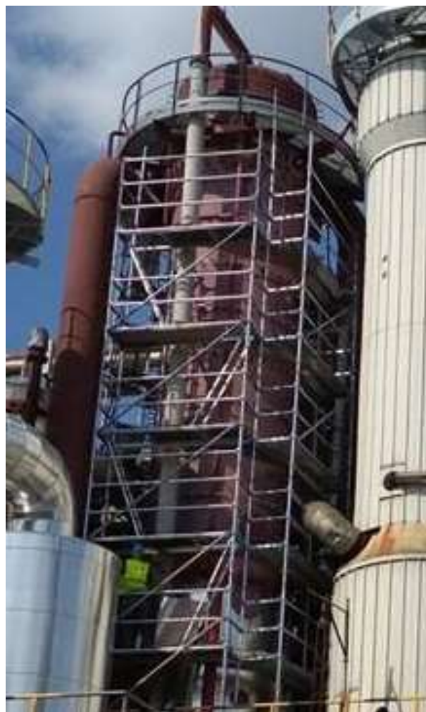
Dział IVB stacji po montażu wraz z orurowaniem
