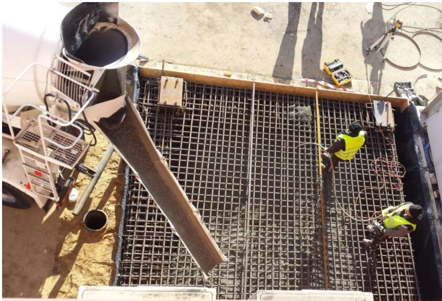
Przygotowanie stopy fundamentowej
