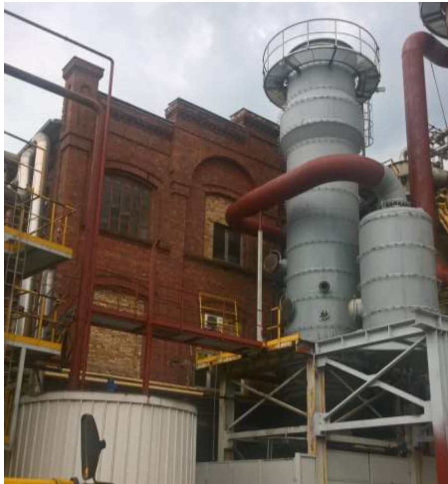
Dział VI stacji po montażu wraz z orurowaniem
