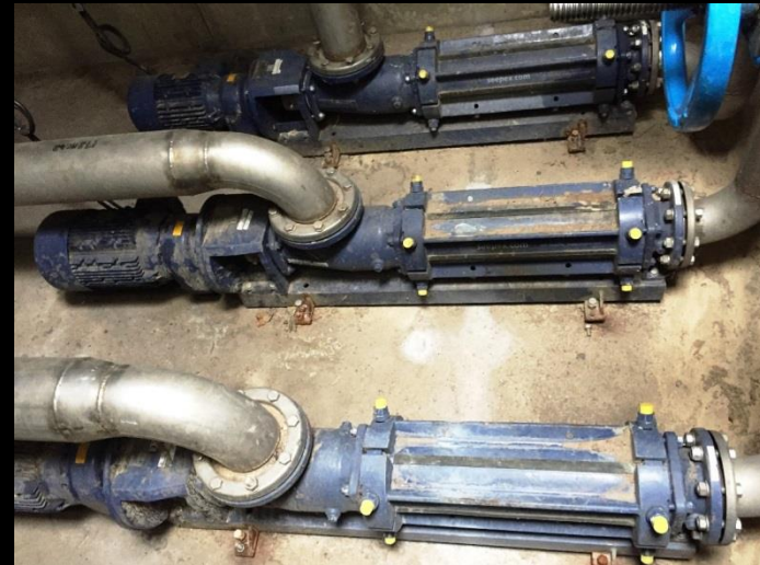
montaż w komorze
