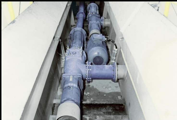
osad zagęszczony; Q = 65\div 265 \text{ m}^3/\text{h} ; H = 2 \text{ bar}
