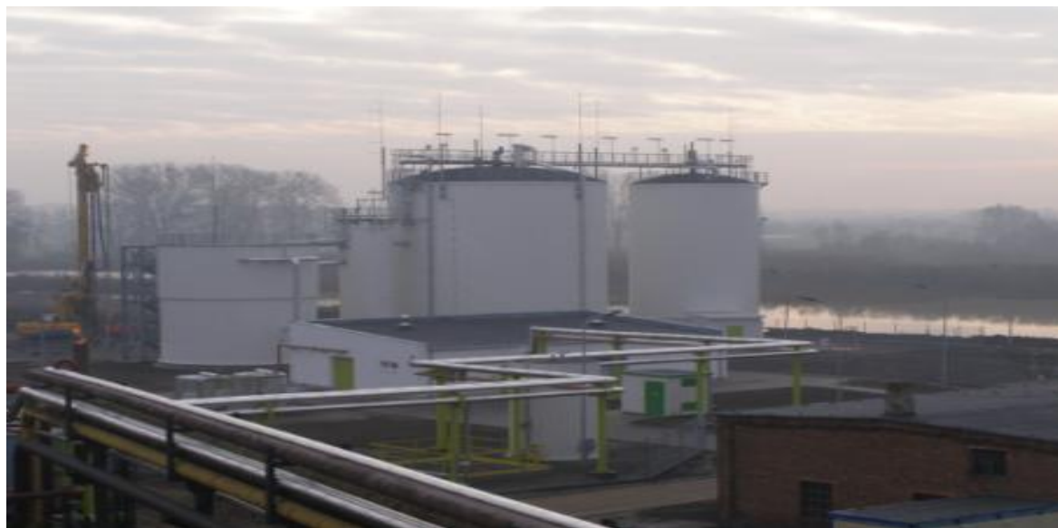
Budowa I etapu oczyszczalni ścieków.
