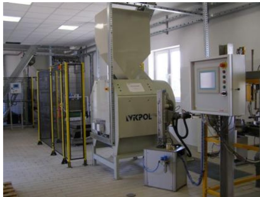
Modernizacja laboratorium surowcowego – I etap
